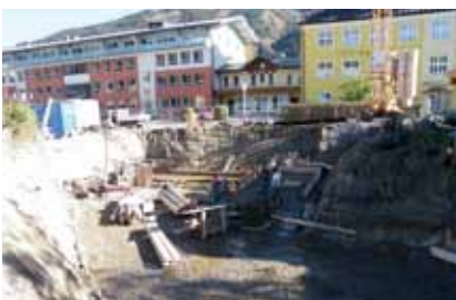
Baugrube für das Objekt betreubares Wohnen in der Schulstraße
