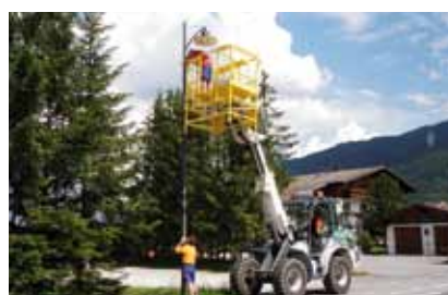
Aufstellen der neuen Straßenbeleuchtung auf der Kapruner Landessstraße
