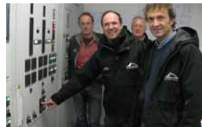
Inbetriebnahme Pump- und Kraftwerk Grubbach - v.l.n.r.: Schneimeister Leo Peter, Ing. Norbert Karlsböck, Dr. Hans-Georg Wechsler (ILF) und Prokurist Ing. Günther Brennstener
