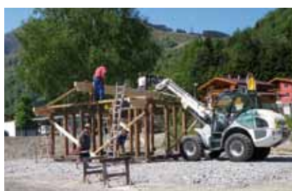
Errichtung Vereinsgebäude Plattenwerferclub
