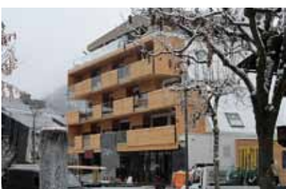
Das neu erbaute Hotel Lederer im Zentrum von Kaprun kurz vor seiner Fertigstellung
