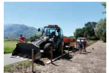
Errichtung der Hundefreilaufzone durch Mitarbeiter des Gemeindebauhofes.
