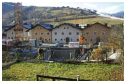
Baustelle für die Wohnobjekte in der Südtirolerstraße
