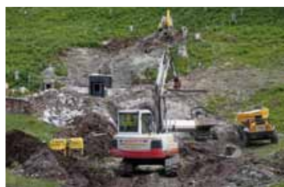
Erneuerung der Quellfassungen am Lechnerberg
