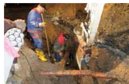
Behebung eines Rohrbruches der Trinkwasserleitung
