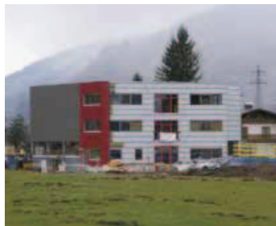
Neubau Schlosserei Flatscher
