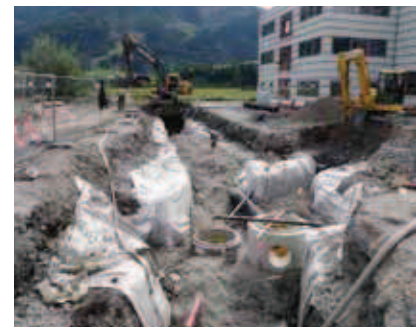
Abwasser- und Trinkwasserleitung im Bereich Gewerbegebiet Sonnstraße
