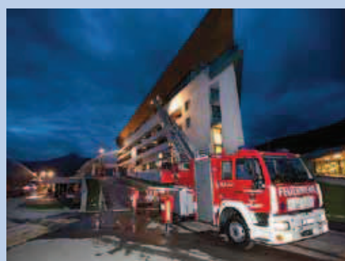
Vor Inbetriebnahme der Tavern Spa wurde eine groß-angelegte Abschnitts-Feuerwehübung durchgeführt
