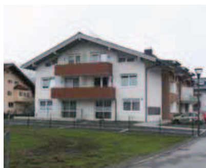
Mitarbeiter-Wohnhaus Tauern Spa
