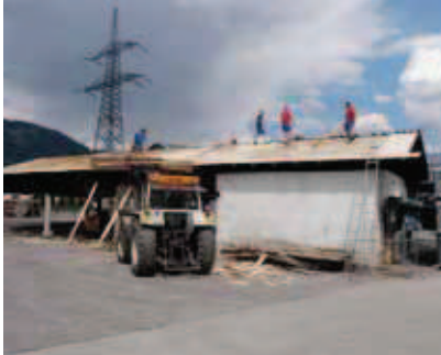
Mitarbeiter des Bauhofes bei der Dachsanierung.
