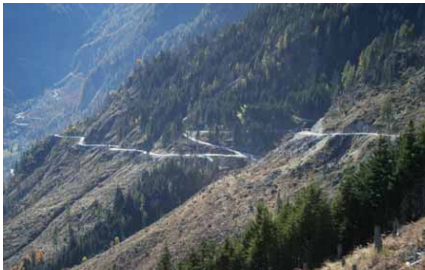
Die Forststraße Astenweg I vom Maiskogel zur Steinerbauernalm wurde im Oktober 2007 mit der Aufbringung einer feinen Schottererschicht fertiggestellt.
