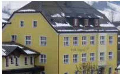
Die Volksschule nach Fertigstellung des ersten Sanierungs-Abschnittes
