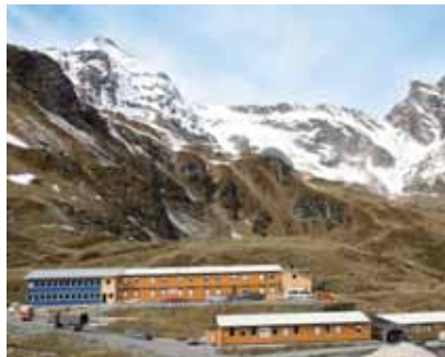
Das Arbeiterwohnlager am Mooserboden wurde um 20 Betten erweitert.
