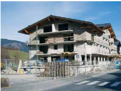
Rohbau Erweiterung Hotel Toni
