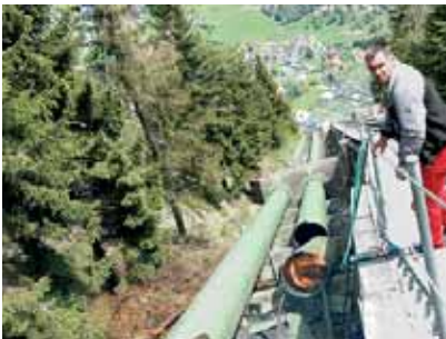
Schwere Arbeitsbedingungen bei den Demontagearbeiten.
