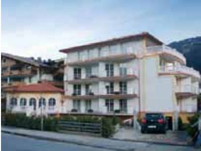
Neubau Hotel Barbarahof
