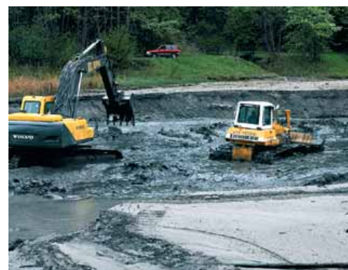
Im Mai wurde der Klammsee entleert. Diese Maßnahme im Abstand von 5 Jahren verhindert eine Auffüllung des Sees durch Sand und Geröll.
