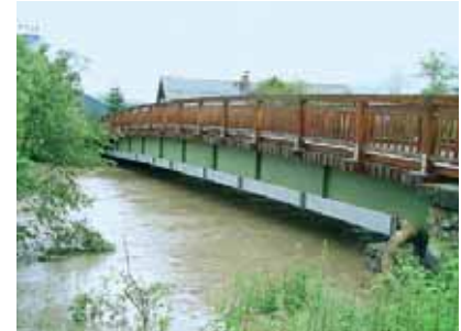
Salzachbrücke am 11. Juli 2005
