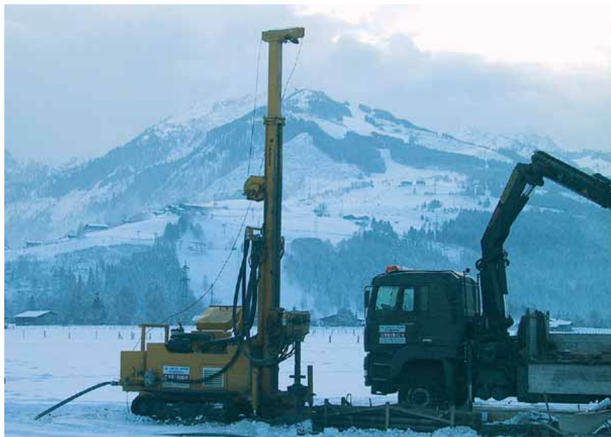
Bodenuntersuchungen am Standort der Tauern Therme Kaprun
