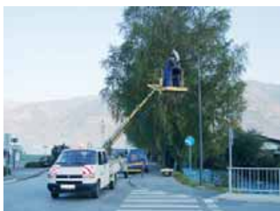
Montage der neuen Schutzwegbeleuchtung.
