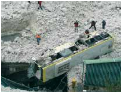
Zerstörungen der Jahrhundertlawine bei der Talstation Lärchwandschrägaufzug
