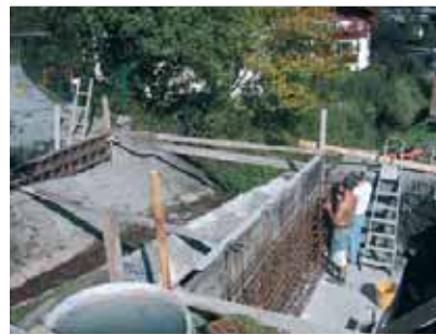
Bau der neuen Unionbrücke über den Menggbach
