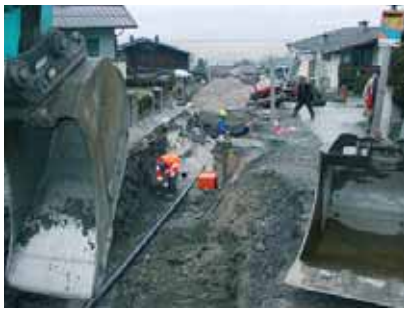
Umfangreiche Erneuerungsarbeiten in der Peter Buchnerstraße
